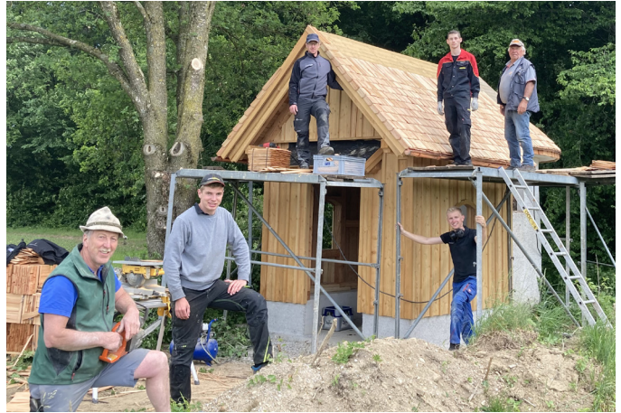
Renovierung der Siebenschläferkapelle
