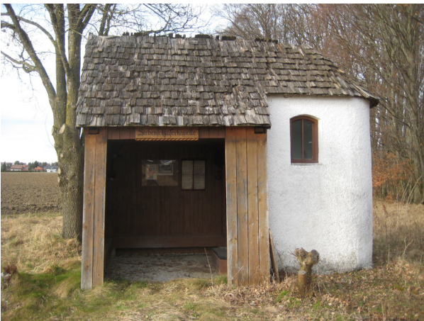
Die Siebenschläferkapelle vor der Renovierung.
