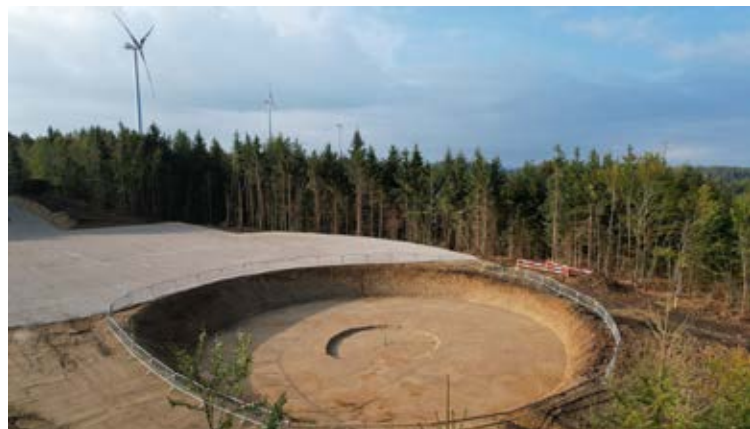
Aktuelles Baustellenfoto (Foto: EWS Consulting GmbH)
