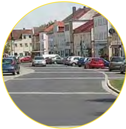
Referenzbeispiel Ortsplatz Wurmansquick, Bayern Planung: ARC Architekten "Farblich abgesetzte Bänder gliedern die Asphaltfläche"
